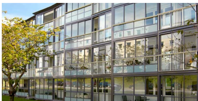
Klimätväggarna både skyddar fasaden och ger stora energibesparingar
