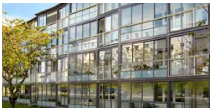
Klimativäggarna både skyddar fasaden och ger stora energibesparingar
