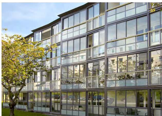
Klimatväggarna både skyddar fasaden och ger stora energibesparingar
